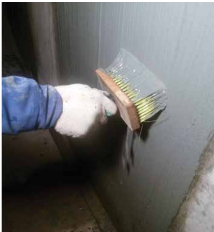
Ручное нанесение минеральной грунтовки. Последующее нанесение ремонтных составов осуществляется "мокрым по мокрому".
