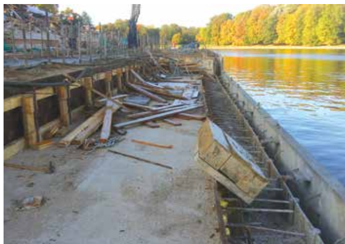
Бетонирование причальной стенки подливочным составом РЕНОВИР Рем60П
