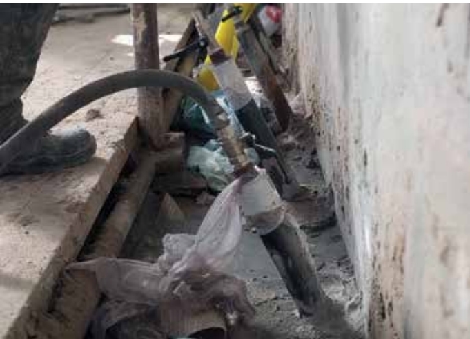
Заполнение дефектов бутового фундамента
