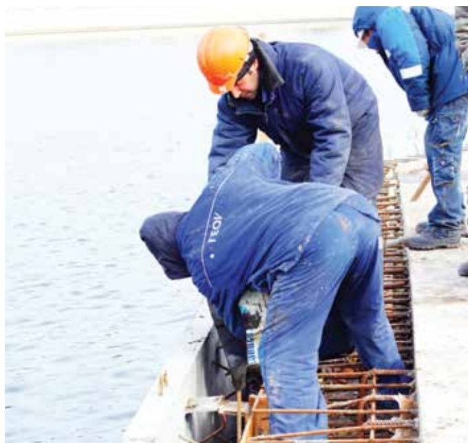
Бетонирование причальной стенки подливочным составом РЕНОВИР Рем60П
