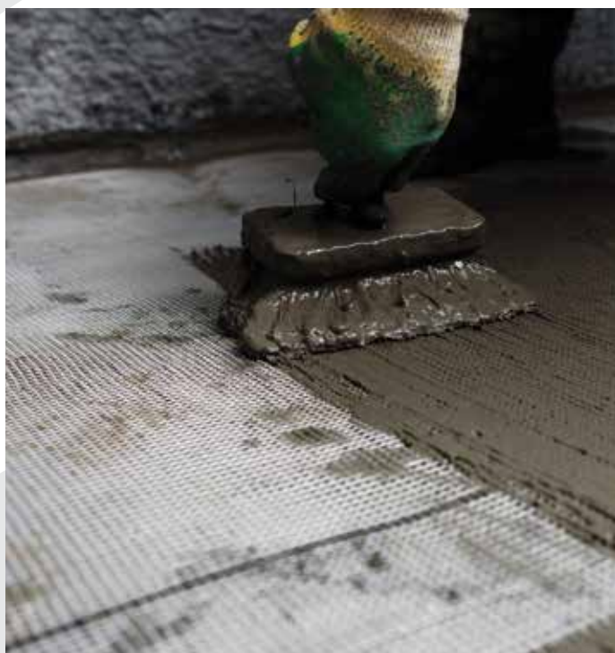
Сетка укладывается в свеженанесенный слой гидроизоляции и перекрывается вторым слоем
