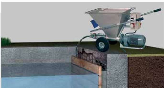
Подводное бетонирование причальной стенки
