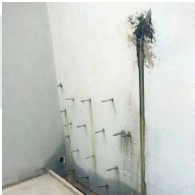
Бурение шпуров в шахматном порядке Расстояние между пакерами 1/2 толщины конструкции Глубина шпуров 2/3 толщины конструкции
